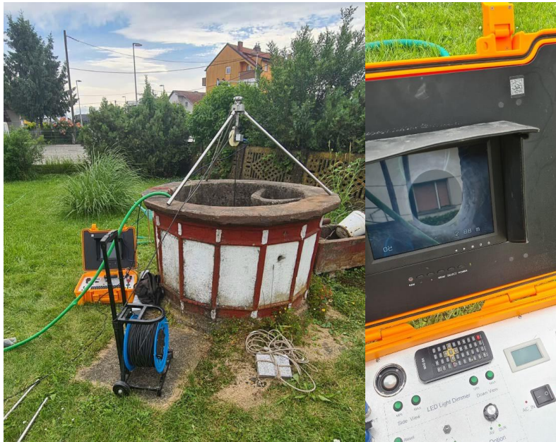
Slika 1.6 Izvođenje radova testiranja i snimanja zdenca
